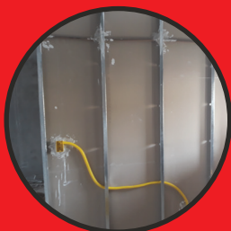
Parede em drywall
